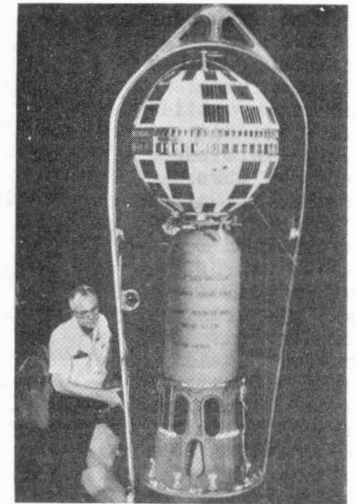
Aktiver Nachrichtensatellit Telstar mit der Drittstufe der Trügerakete Douglas Delta. Beim Start schützt eine später abfallende Verkleidung den empfindlichen Satelliten. - The Telstar active communications satellite together with the third stage of the Douglas Delta booster rocket. During launch a jettisonable casing protects the delicate satellite.
